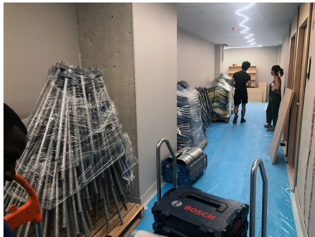
3. On prépare le matériel pour le montage et le placement dans les chambres.
